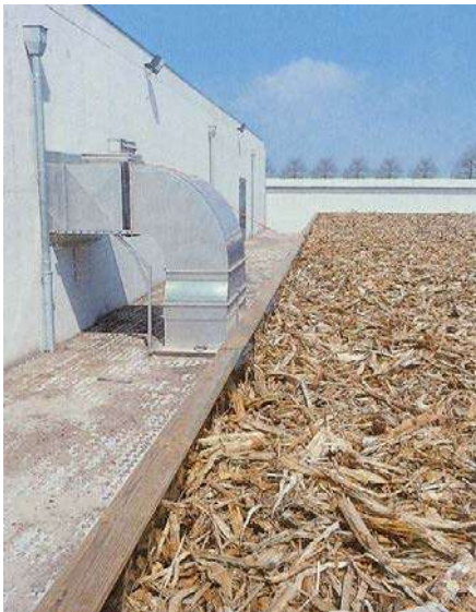
Рисунок 2.4.3 – Вид биофилтра с открытой поверхностью и системой увлажнения
