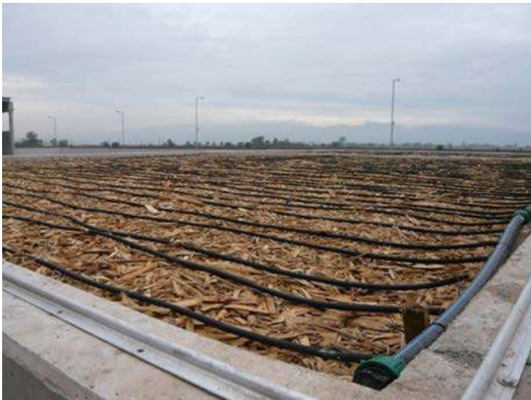
Рисунок 2.4.3 – Вид биофилтра с открытой поверхностью и системой увлажнения
